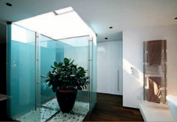
Elektrochromatické sklo sa jednoduchým vypínačom mení na nepriehľadné.
